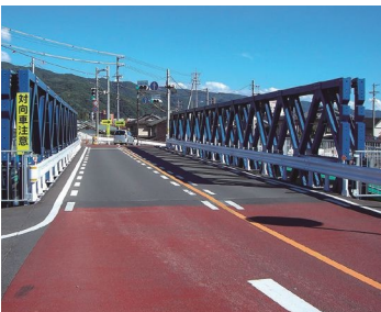
仮橋（長野県下諏訪町）
