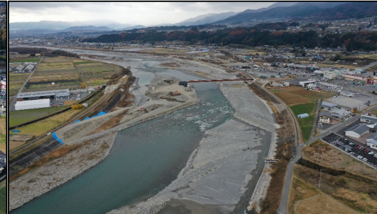
3.河川内土工(左岸側架設ヤード造成)
