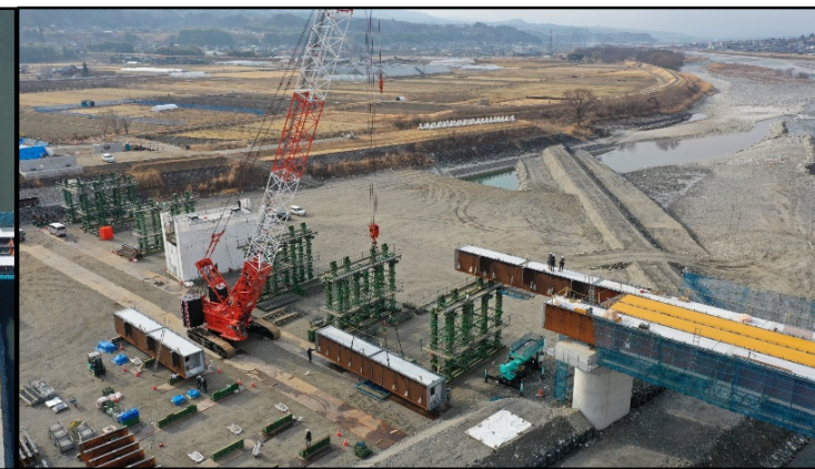
7.架設工(桁地組)
