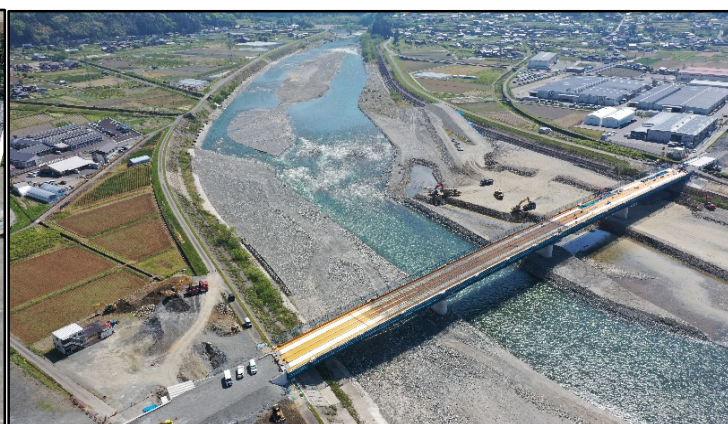
14.床版工(コンクリート打設完了)
