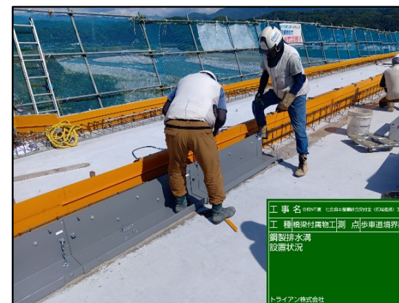
15.橋梁付属物工(鋼製排水溝設置)
