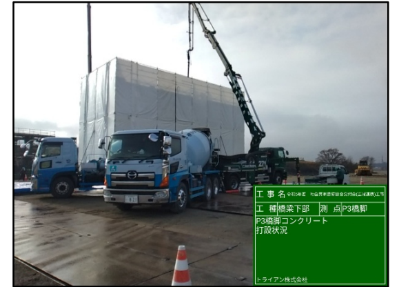
4.RC橋脚工(P3橋脚梁部施工)
