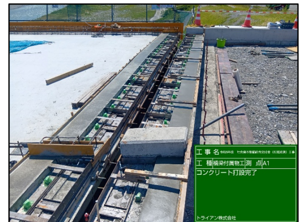
16.床版工(地覆コンクリート打設)
