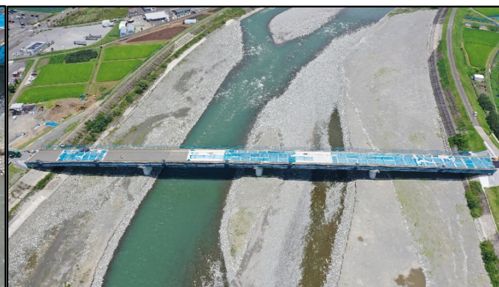
14.床版工(コンクリート打設完了)
