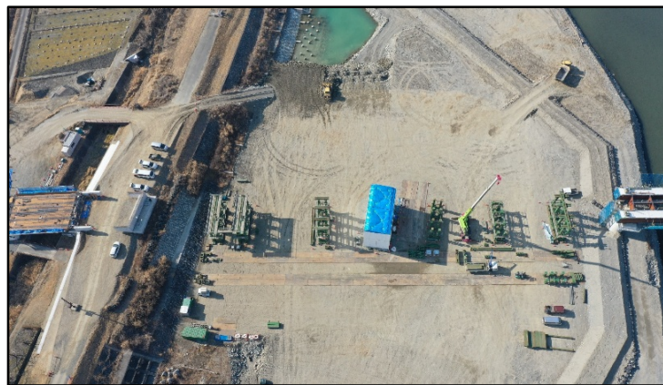
6.架設工(鋼製ベント組立て)
