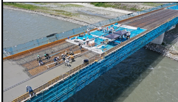
13.床版工(コンクリート打設)
