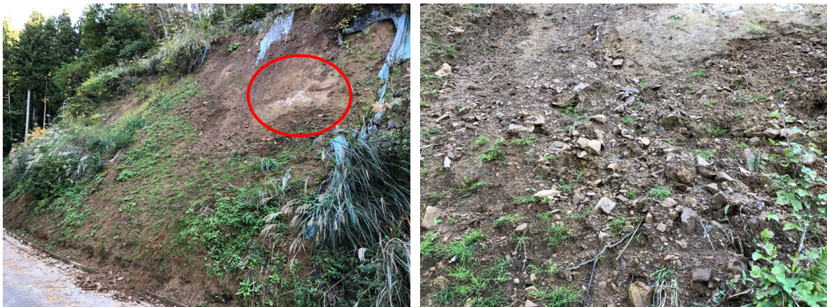
写真 2-2. No. 2 崩壊地（赤丸箇所にて調査）
