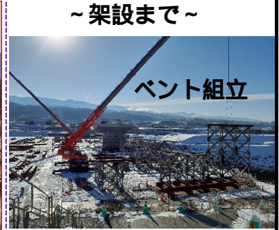
2月29日 架設状況
