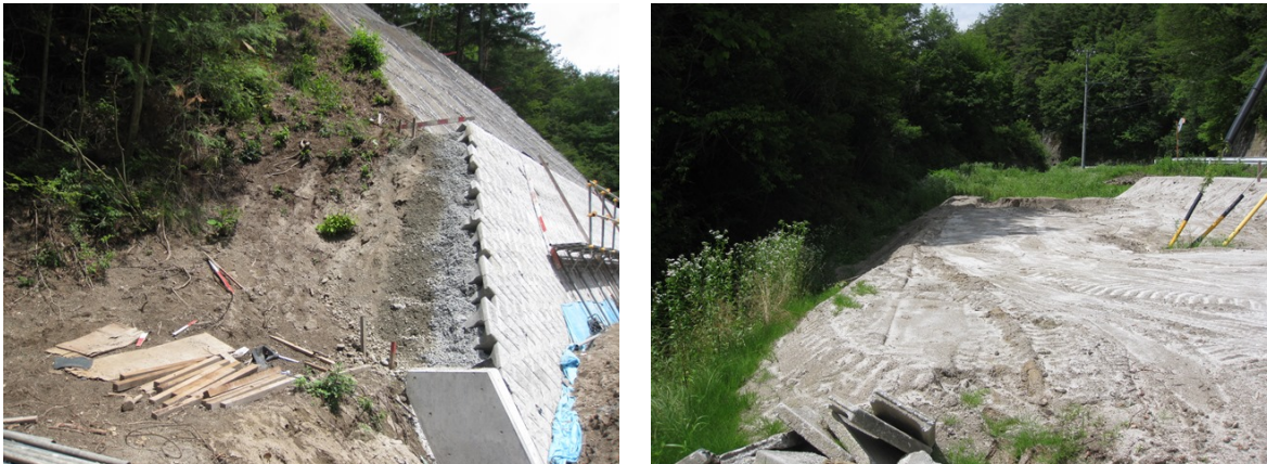
写真 2-1. 盛土法面造成予定箇所（左：間地ブロック擦り付け部，右：土捨て場）
