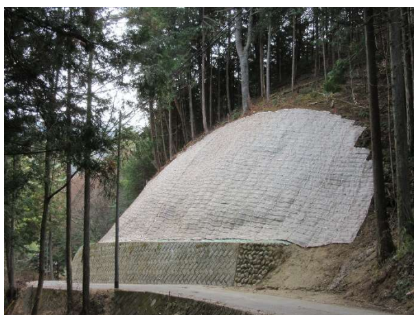
施工完了：H28年12月
