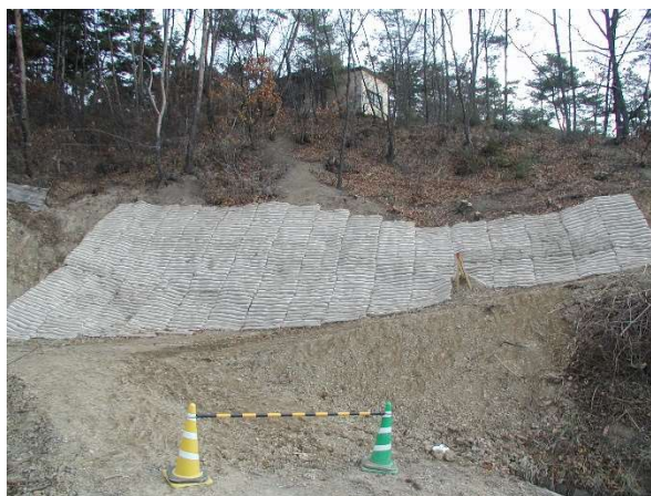
施工完了:H15年3月
