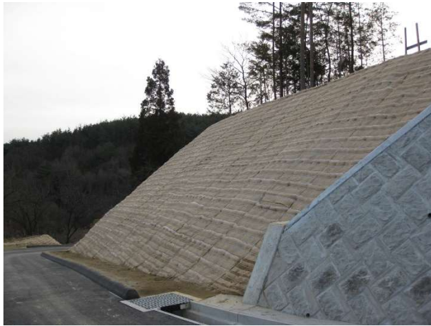
施工完了：H25年3月
