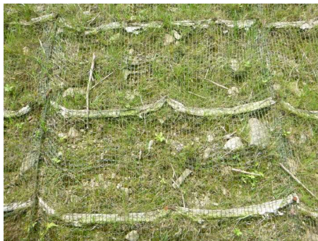
アーチブロック未設置箇所
